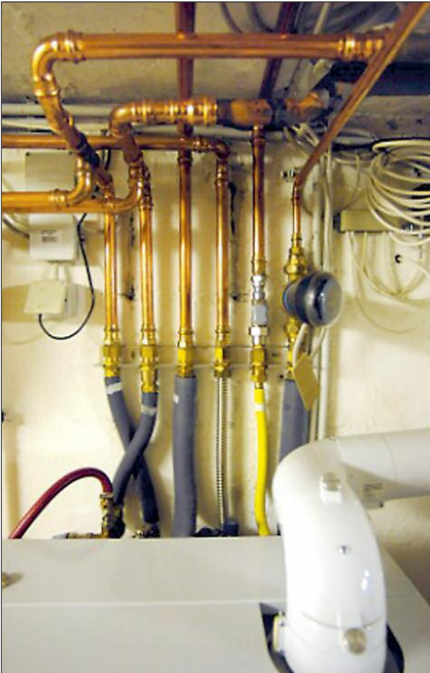
Abb. 20: Einbausituation von Dämmung
